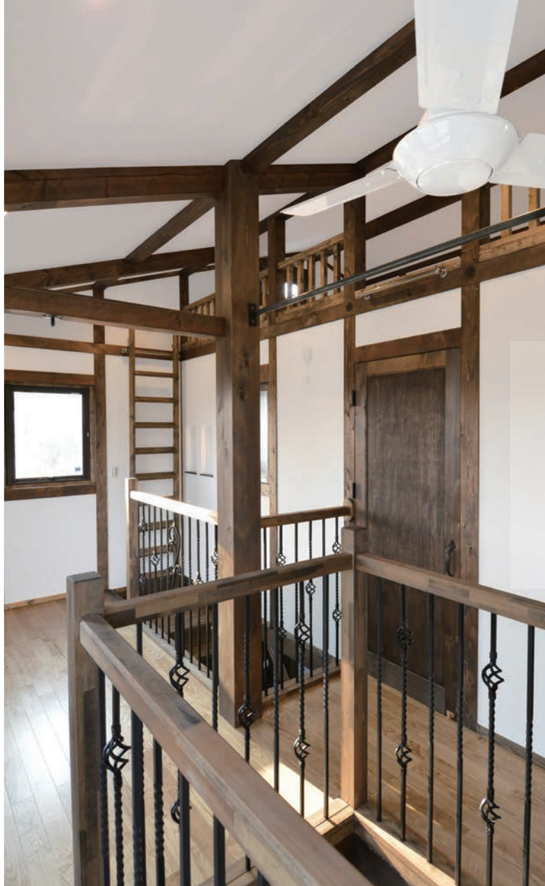
柱や梁を見せることで空間をより広く魅せる「真壁工法」。
