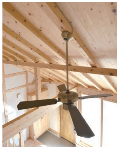
空気を循環させ、部屋中の温度差を無くすシーリングファン。
