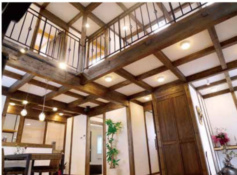
柱や梁を表す真壁づくりならではのダイナミックな吹抜け空間。
